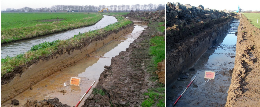
Afb. 4. Het graven van een archeologisch vlak ten behoeve van het verbreden van een bestaande watergang (links) of het graven van een nieuwe watergang (rechts).
